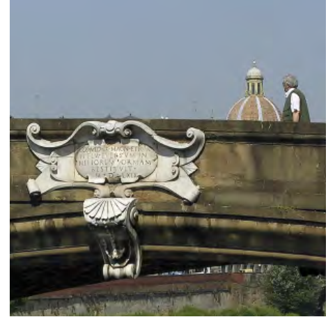
1952-1958 Firenze, Riconstruzione del ponte Santa Trinita , E. Brizzi, R. Gizdulich
