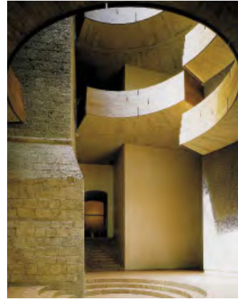
1969-1978 Siena, Sede centrale del Monte dei Paschi di Siena , Pierluigi Spadolini
