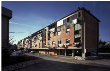
1960-1965 Massa, Complesso INA Casa San Leonardo , Edoardo Detti
