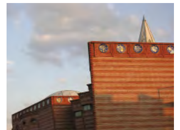
1991-1996 Montelupo Fiorentino, Distretto socio-sanitario , Marco Dezzi Bardeschi
